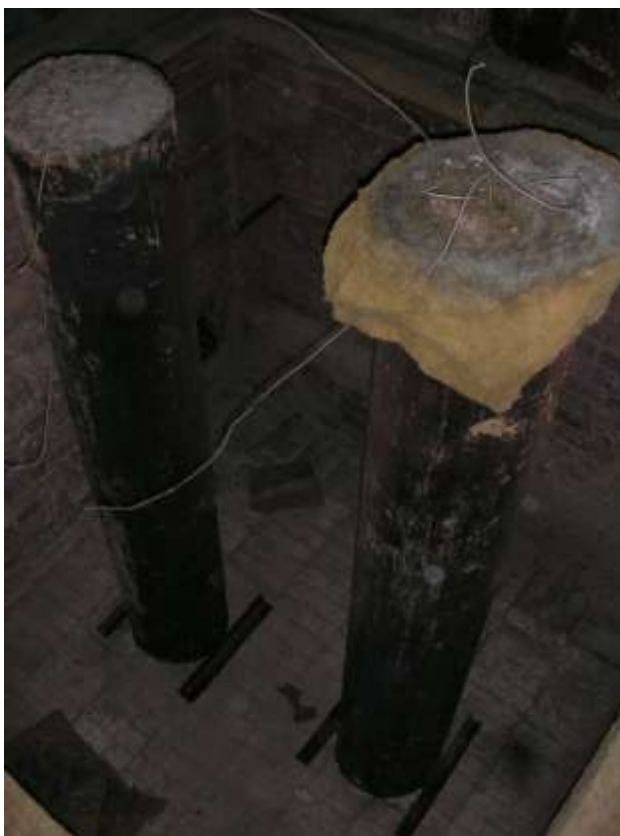
Рисунок 4.13. – Вигляд трубобетонних колон-зразків після проведення вогневих випробувань
