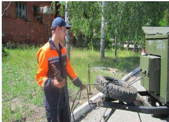
Рис.1.3. Перевірка надійності контактів в зварювальному ланцюзі
