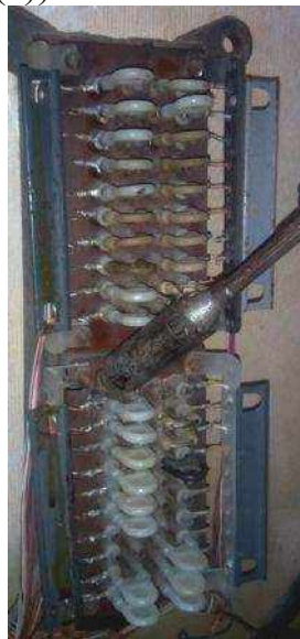
Рис.3.7 (а). Монтаж міжміського боксу
