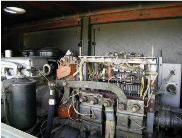
Рис.1.3 (а). Огляд спец. установки АПА-35/30 на наявність пошкоджень
