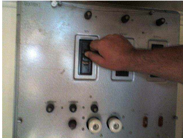
Рис. 3.25 (а). Вимкнення автомату "СЕТЬ"
