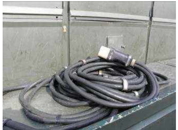
Рис.1.6 (б). Змотати заземлення
