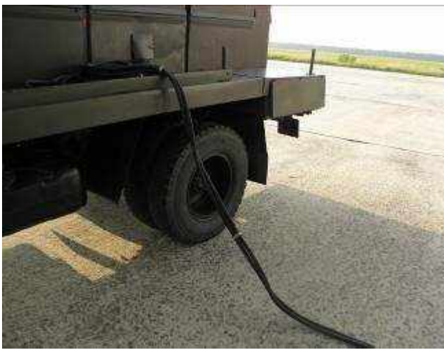
Рис.1.5 (а). Розгортання силового кабелю АПА-35/30
