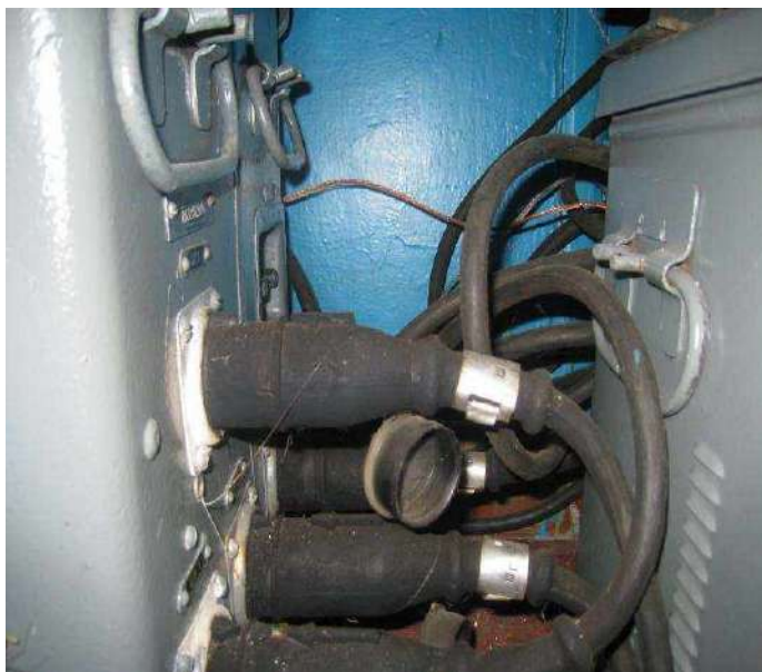
Рис. 3.22 (а). Підключення світломаяка до агрегату живлення
