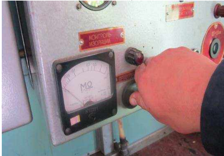
Рис. 7.5. Перевірка роботи захисно-вимикаючих пристроїв
