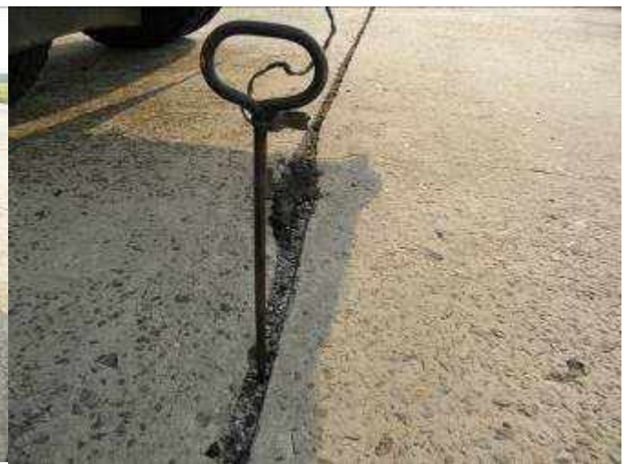
Рис.1.5 (б). Встановлення заземлення
