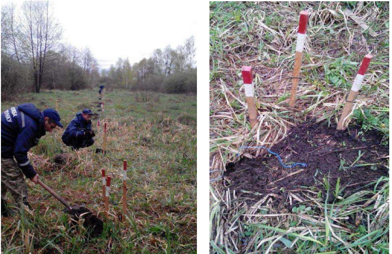
Рис. 4.4.5. Порядок засипки шпурових зарядів
