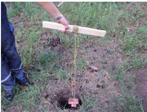
Рис. 4.5.3. Опускання заряду в лунку
