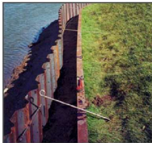
Рис. 2.7. Способи берегоукріплення: а) дубовим брусом; б) георешіткою; в) габіонами; г) матрац Рено; д) шпунтом
