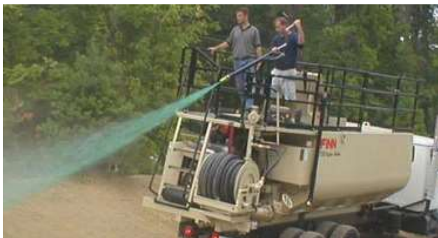
Рисунок 1.6 – Гідропосів сміттєзвалища за допомогою гідросівалок «FINN»
