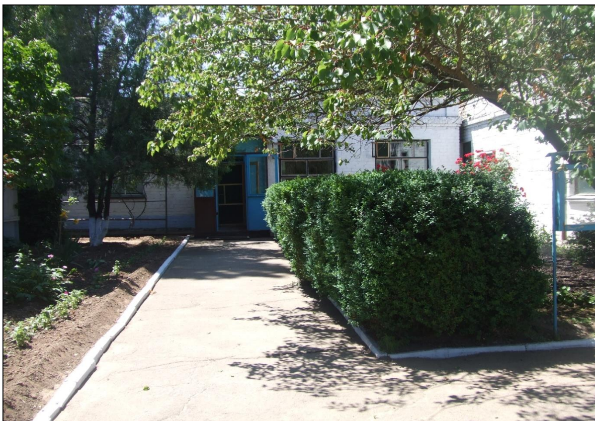
Рисунок 2.1 – Адмінбудівля Херсонських очисних споруд.
