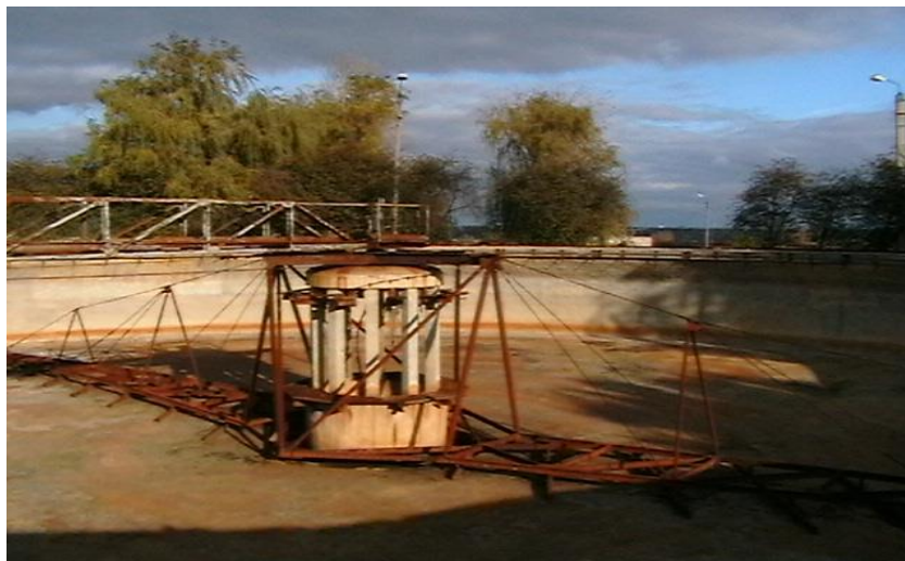
Рисунок 3.2 – Очисні споруди м. Херсона (радіальний відстійник).
