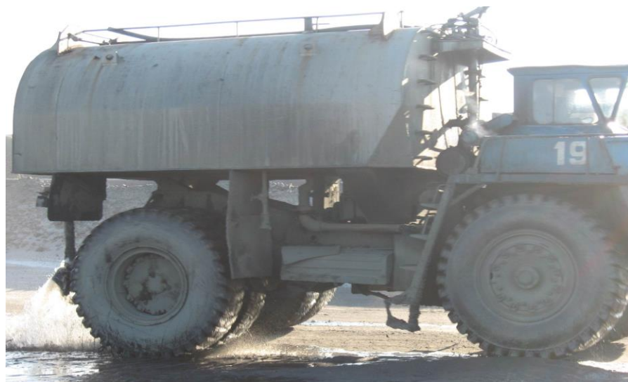
Рисунок 6. Нанесення бішофіту на закріплювану поверхню.
