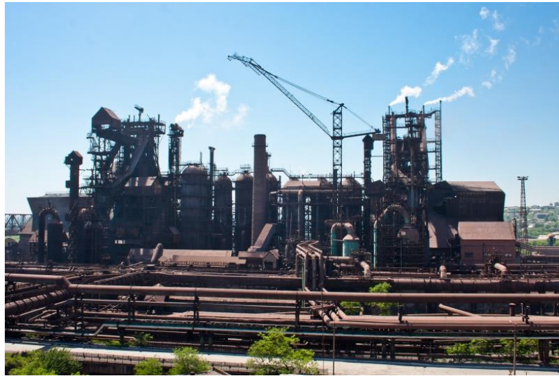
Рис. 1.4. Конвертерне виробництво (конвертерний цех)
